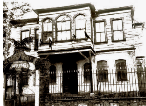
Eski Hükümet Konağı
